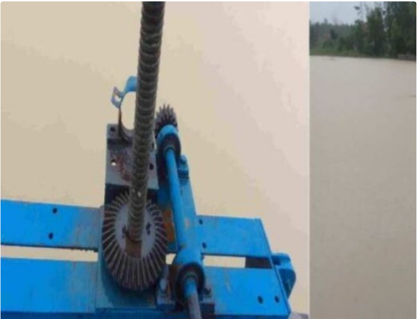
Pintu air Albaret Simpang Mesuji
